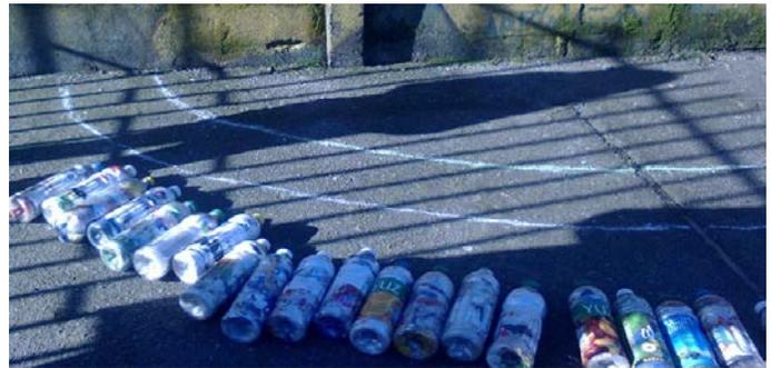
**3-** Mide los metros lineales de tu construcción y considera que necesitarás aproximadamente 36 ecoladrillos para un metro lineal de construcción (4 filas en altura por 9 botellas por metro lineal).
