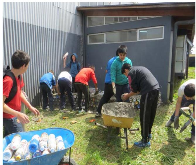
**9-** Repite este proceso hasta alcanzar la cuarta fila de ecoladrillos. Para la última capa de cemento, se recomienda hacer una mezcla más concentrada de cemento y sin gravilla, para que quede suave y firme. Esta mezcla se puede hacer 1 pala de cemento por 2 de arena. Esta última capa debe ser gruesa, por lo que se recomienda echar una primera capa, esperar 10 a 20 minutos y volver a echar otra capa antes de que seque, para alcanzar un mayor grosor sin escurrir.
