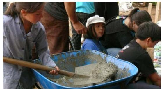
Revuelve con una pala la mezcla seca y agrega lentamente agua hasta que la mezcla quede homogénea. La cantidad de agua es asegurándose que la mezcla quede espesa, de manera que no escurra y no necesitamos de molde para nuestra construcción.
