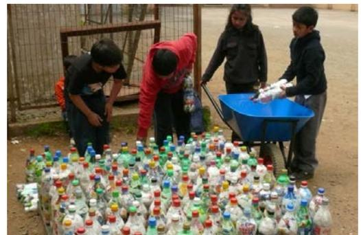
**5-** Si ya tienes todos los ecoladrillos necesarios para la construcción, comienza a hacer la mezcla de cemento. Para ello se aconseja una mezcla de 1 pala de cemento por una de gravilla y dos de arena. Ejemplo: Si en la carretilla echas 8 paladas de arena, tendrás que echar 4 de cemento y 4 de gravilla.
