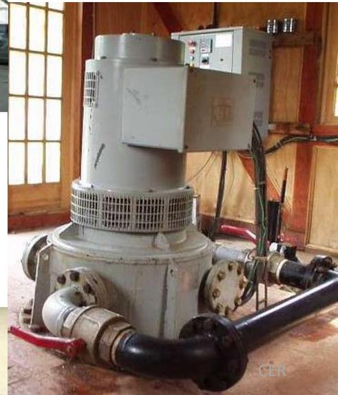
**Centrales portátiles:** Son dispositivos de muy baja potencia, pero que no requieren una base fija y pueden ser fácilmente reinstalados.
